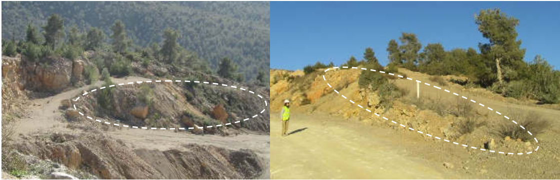
Imagen nº 7 y 8: Taludes en revegetación natural debido a la sucesión ecológica facilitada desde las zonas perimetrales, que se encuentran preservadas en su estado original.
